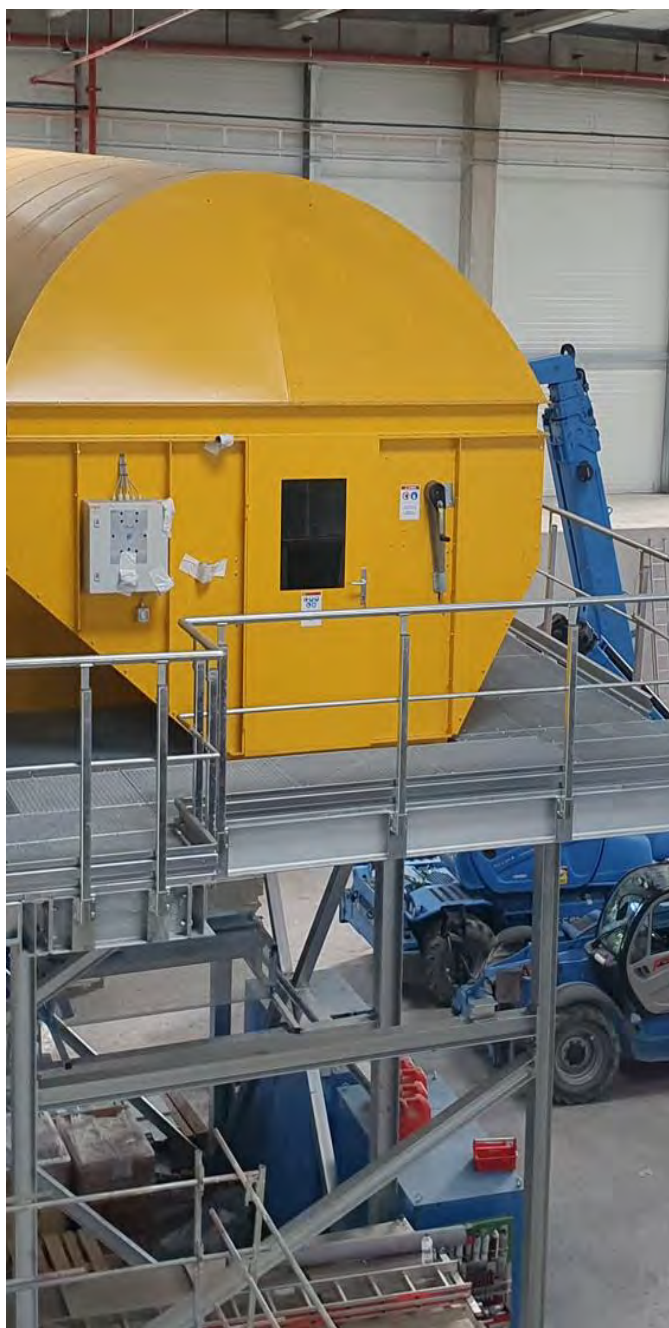
Installation du trommel – octobre 2024
