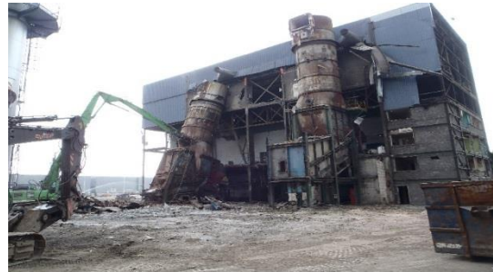
Démantèlement four n°2 le 17 Mars
