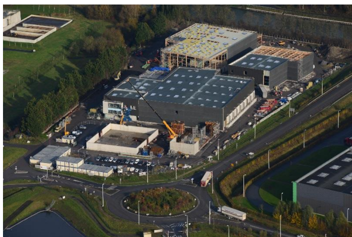
Chantier du TVME – 24 novembre 2014
