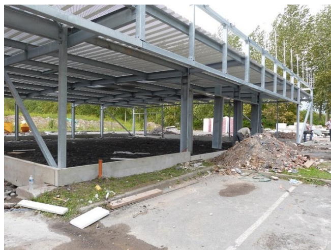
Chantier magasin Ressourcerie – 14 août 2014
