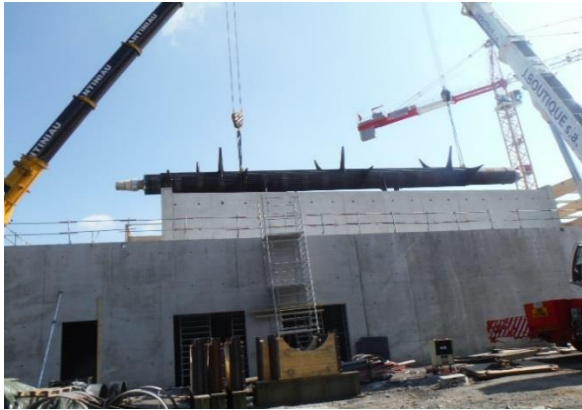
Mise en place des axes de DAMP sept 2014
