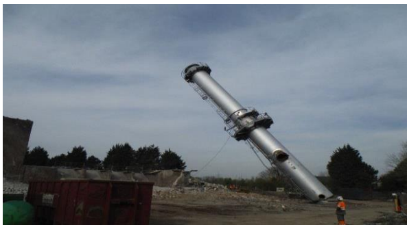
Démantèlement cheminée au 02 Avril
