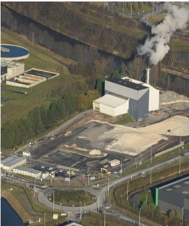
Chantier TVME – le 18/11/2013
