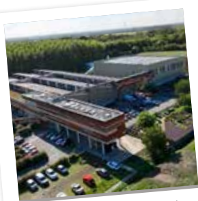
2011 - Centre de tri des emballages
