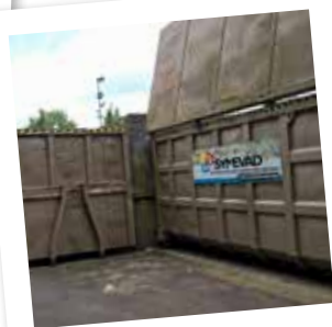
Bas de quai des déchèteries
